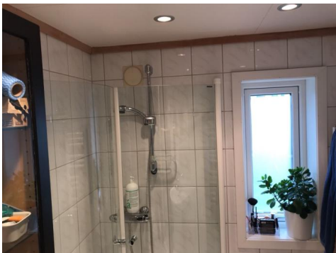
Bildet viser vindu i våtsonen.
